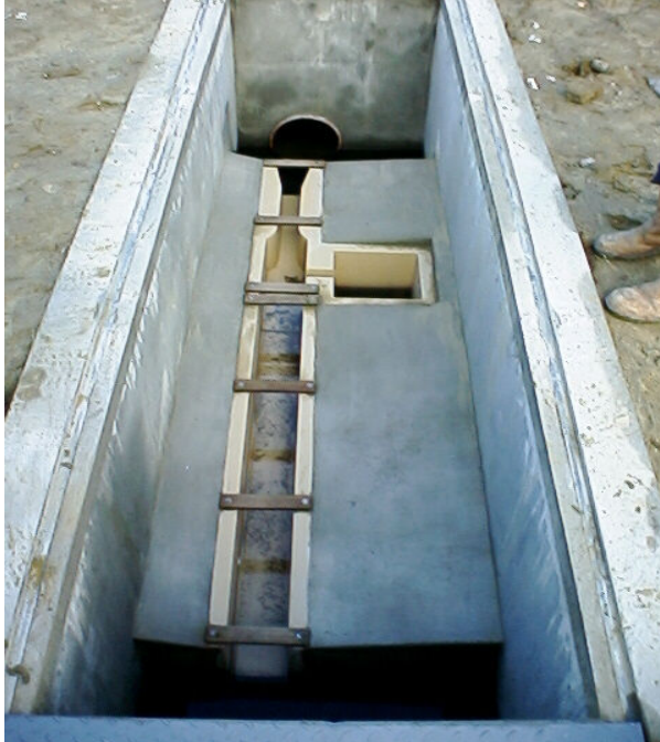
Venturi-flume in polyester of RVS Met / zonder laterale meetkamer
